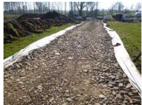
Exemple de piste provisoire sur géotextile.
