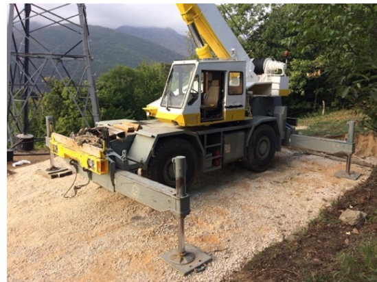
Levage des supports à la grue.
